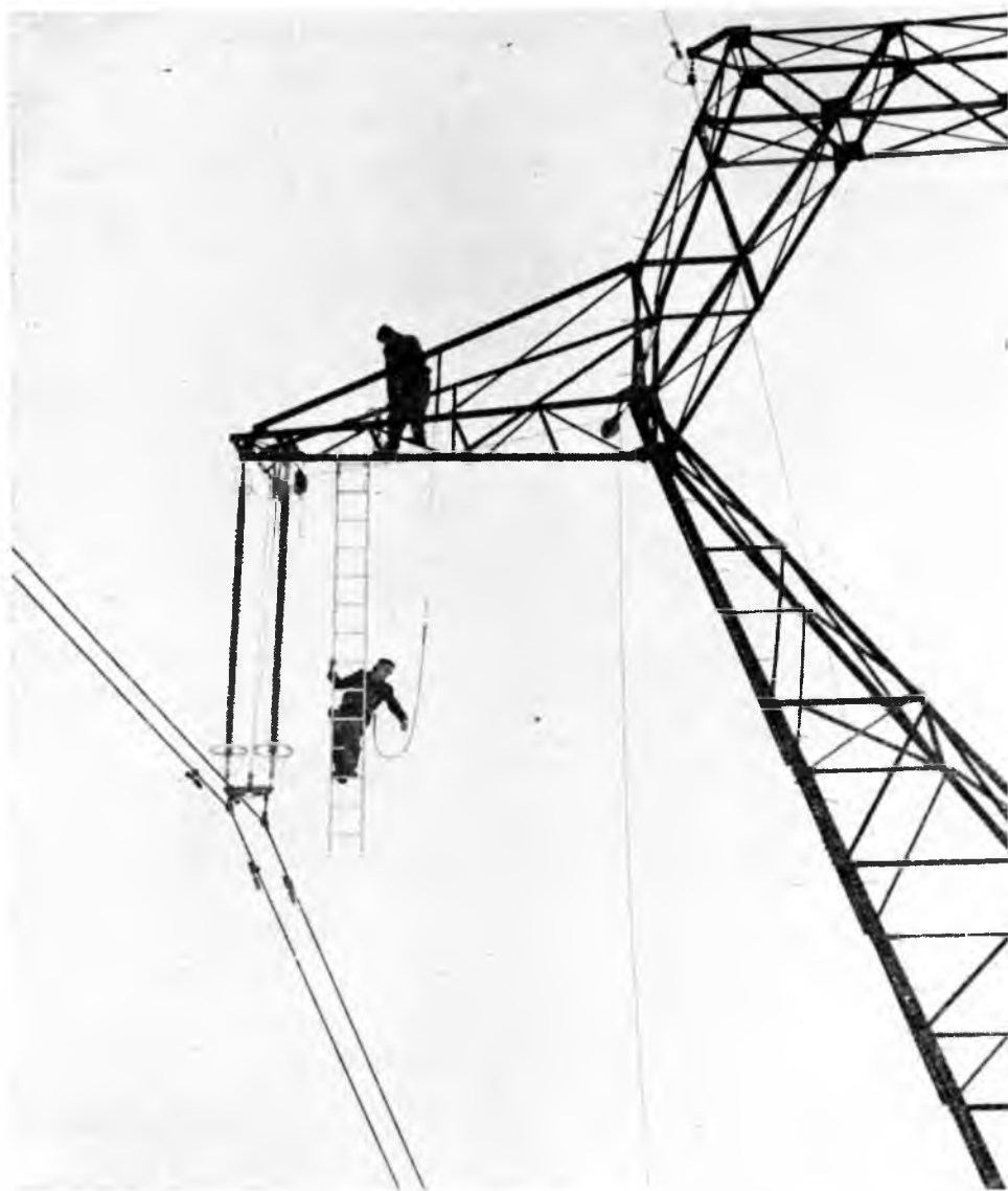
22-8. ábra. A 400 kV-os hosszúrúdszigetelők szerelése a Göd—I.éva távvezetésekre
