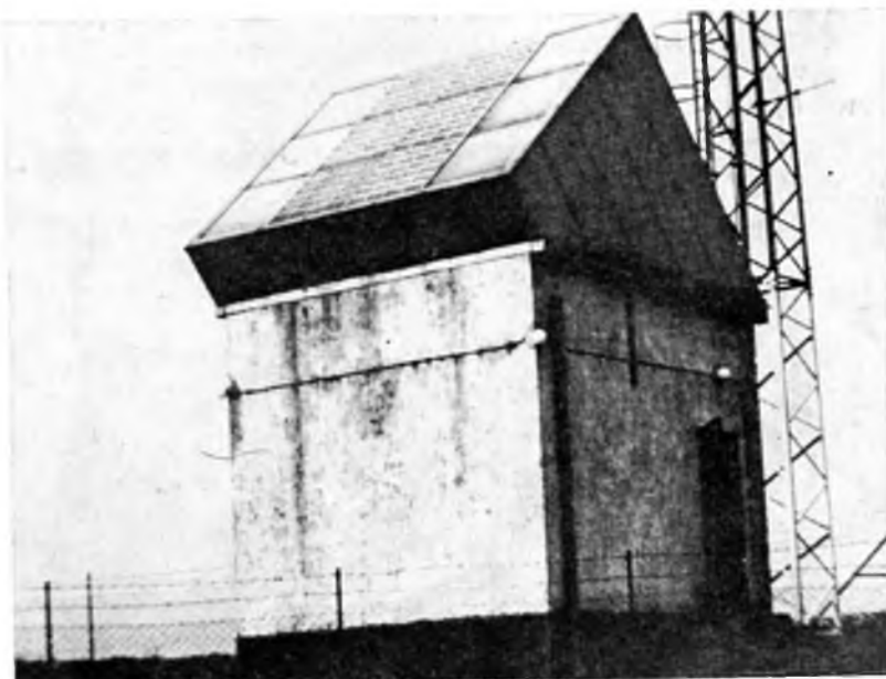
13-7. ábra. Tetőre szerelt napelemes egység
