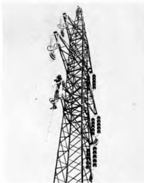
22-7. ábra. A 120 kV-os hosszúrúdszigetelők felszerelése
